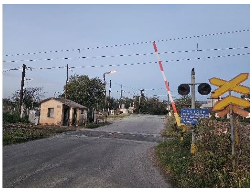
Φωτογραφία 2.1: Σιδηροδρομική Διάβαση στη Χ.Θ. 9+860
