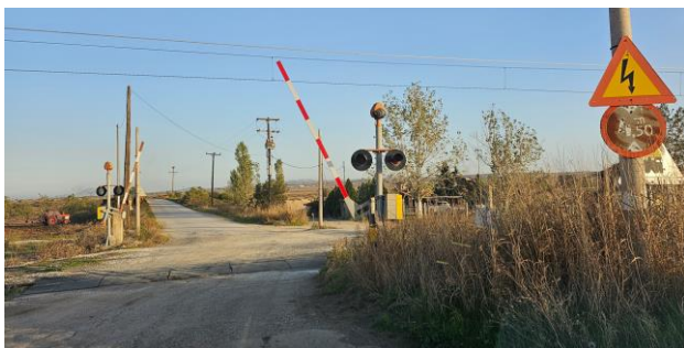
Φωτογραφία 2.7: Σιδηροδρομική Διάβαση στη Χ.Θ.38+080
