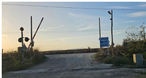
Φωτογραφία 2.8: Σιδηροδρομική Διάβαση στη Χ.Θ.38+080
