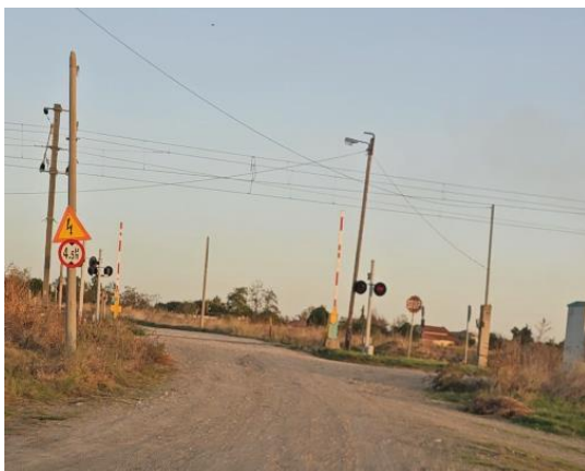
Φωτογραφία 2.5: Σιδηροδρομική Διάβαση στη Χ.Θ.35+450
