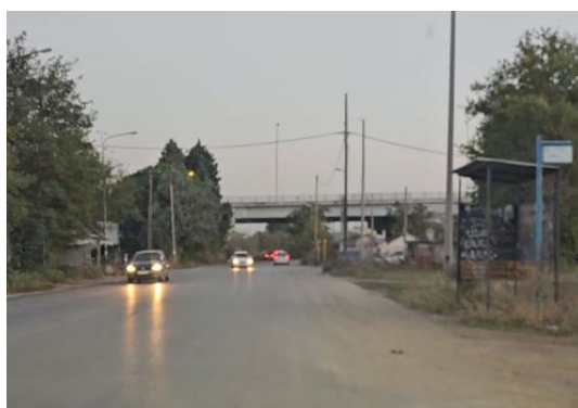
Φωτογραφία 2.3: Στάση λεωφορείων πλησίον της Χ.Θ. 9+860
