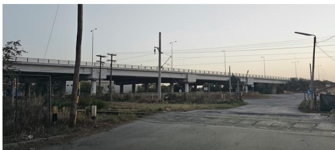
Φωτογραφία 2.2: Σιδηροδρομική Διάβαση στη Χ.Θ. 9+860
