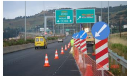
Εικόνα 4.2: Προστατευτικό πλέγμα ασφαλείας για περιοχές εκτέλεσης έργων
