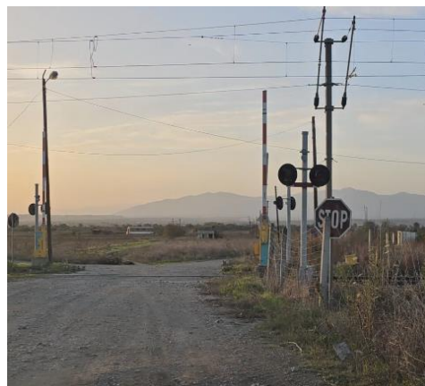
Φωτογραφία 2.6: Σιδηροδρομική Διάβαση στη Χ.Θ.35+450
