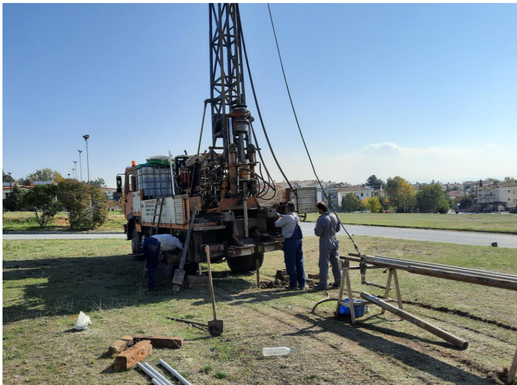
Φωτ. 2: Θέση Γεωτρήσεως Γ2
