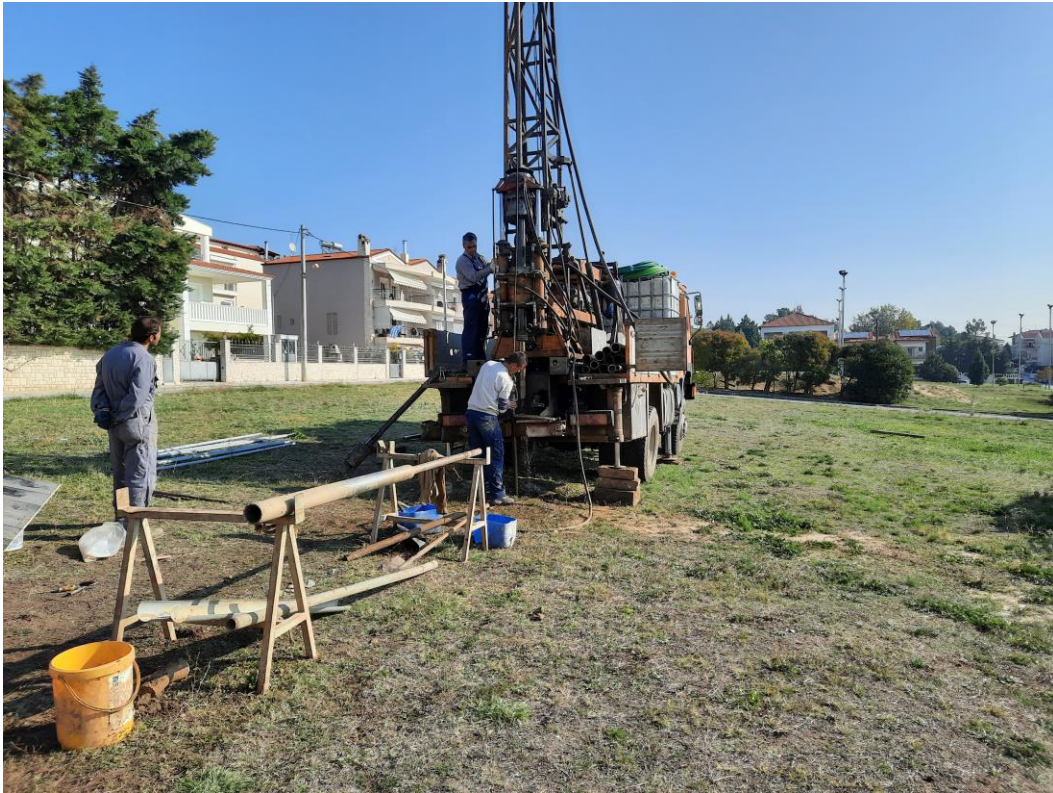
Φωτ. 1: Θέση Γεωτρήσεως Γ1
