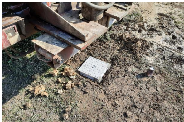
Φωτ. 9: Κεφαλή πιεζομέτρου Γεώτρησης Γ2
