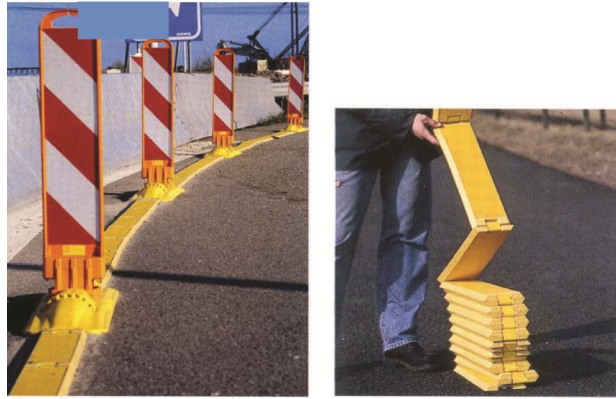
Σχήμα 5: Παράδειγμα οριοθέτησης διαδρόμου κυκλοφορίας (πινακίδες, οριογραμμή και ανακλαστήρες στις βάσεις στήριξης των πινακίδων)
