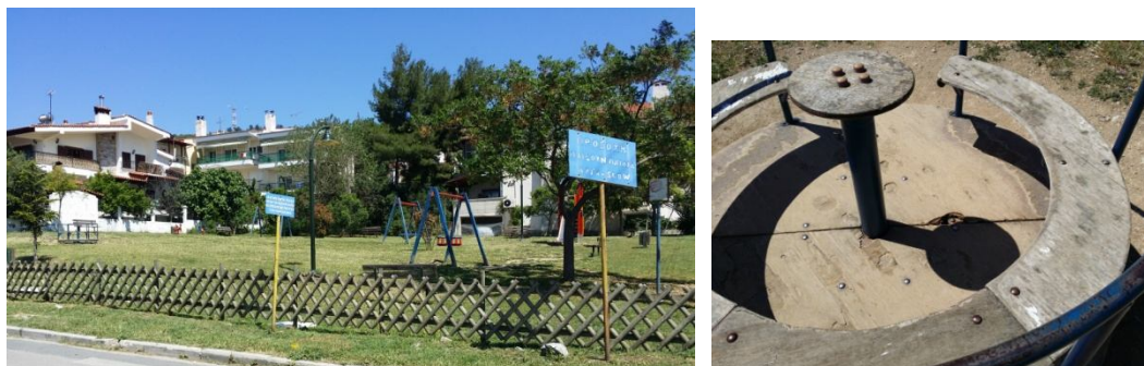
Φωτ. 3: Επικίνδυνες και κατεστραμμένες κατασκευές, Έλλειψη υλικού απορρόφησης κρούσεων.
