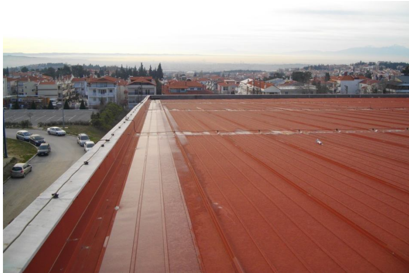
Άποψη οροφής κλειστού γυμναστηρίου Ωραιοκάστρου
